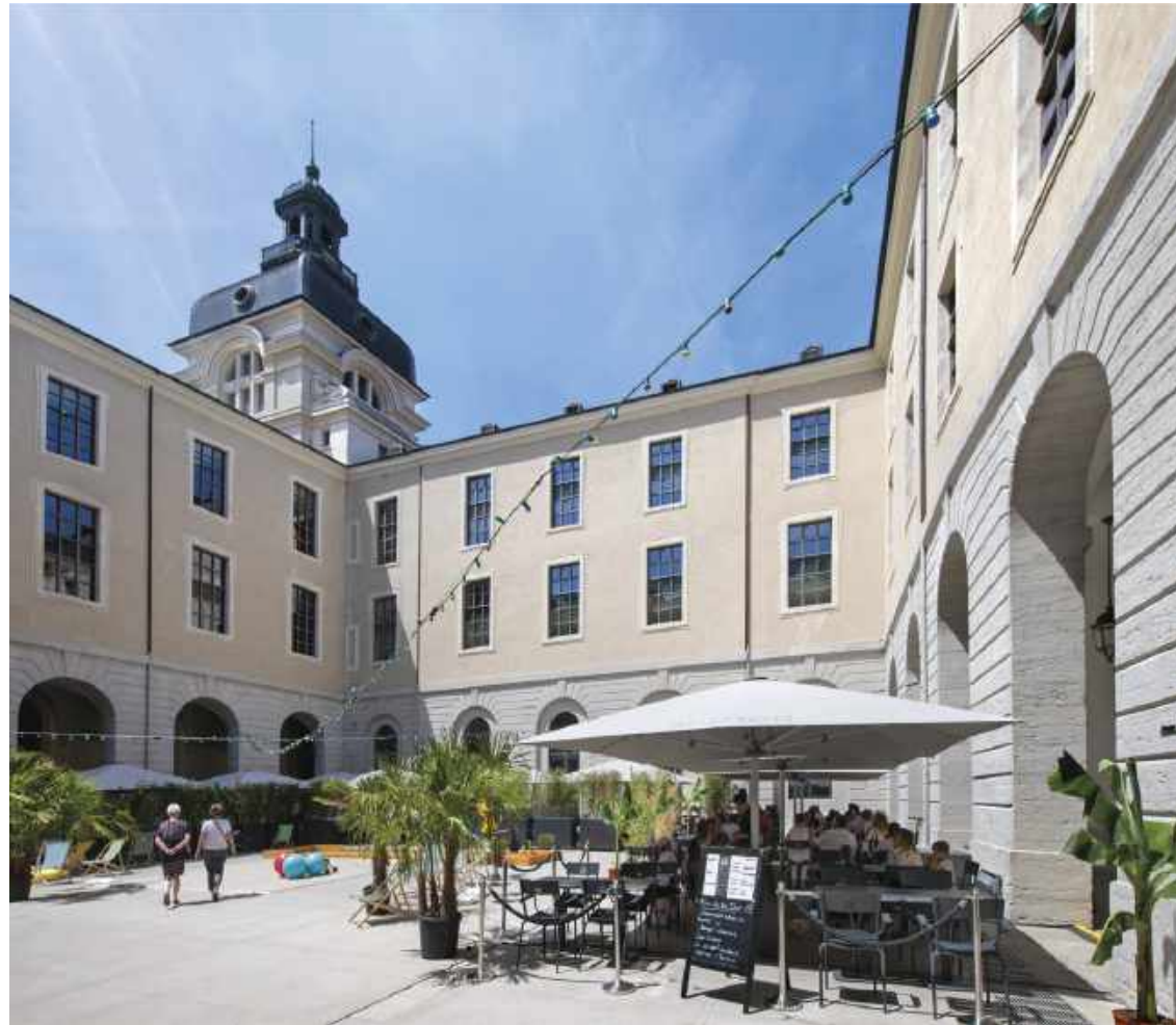
Au cœur de l'Hôtel-Dieu, deux restaurants bordent la cour Saint-Martin qui se transforme alors en scène de spectacle pour des événements festifs ponctuels. Two restaurants are located along the sides of Saint-Martin courtyard in the middle of the Hôtel-Dieu, which also serves as a stage for occasional festive events.
