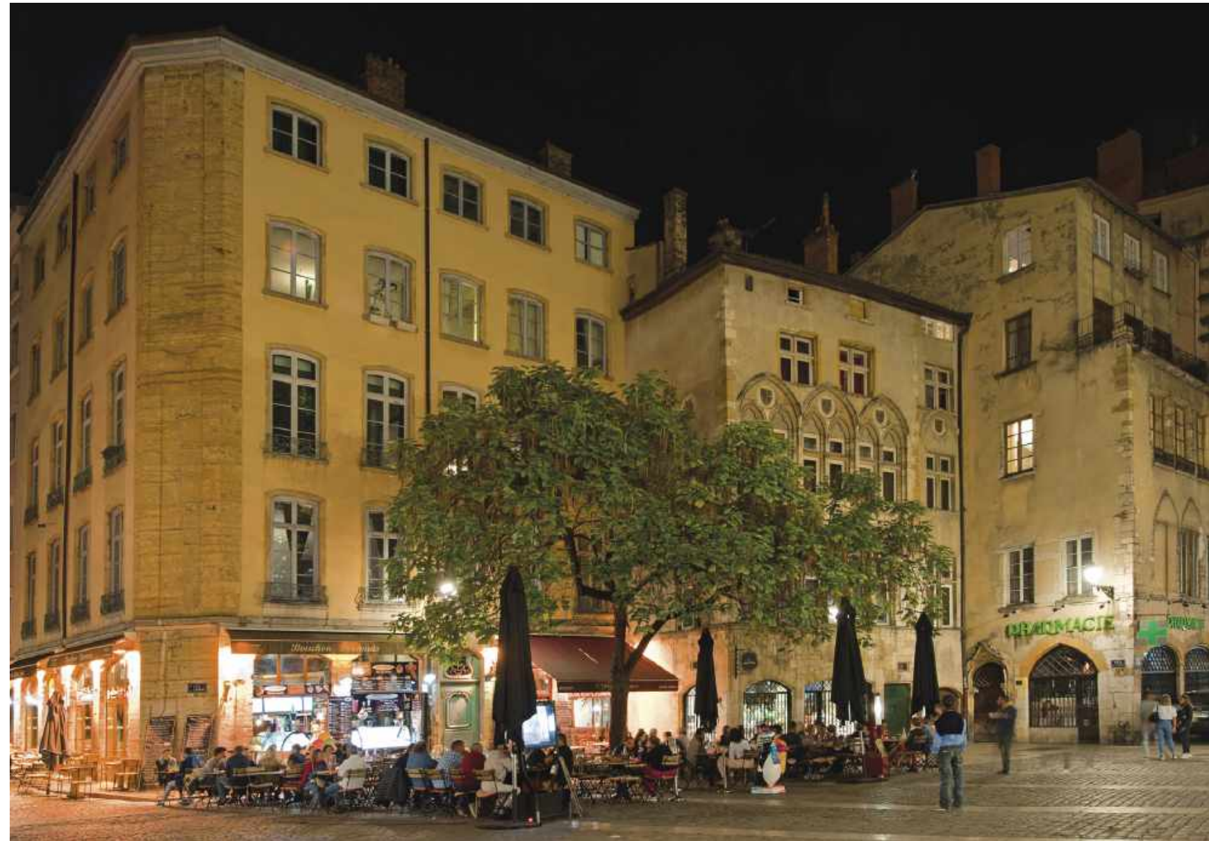
Fenêtres à meneaux, fines colonnettes, arcs ogivaux... La richesse de l'architecture du Vieux-Lyon se lit sur la façade de la maison Thomassin, place du Change. Mullioned windows, slender columns, and ogive arches: Old Lyon's architectural riches stand out on the Thomassin house, on place du Change (Stock Exchange Square).
