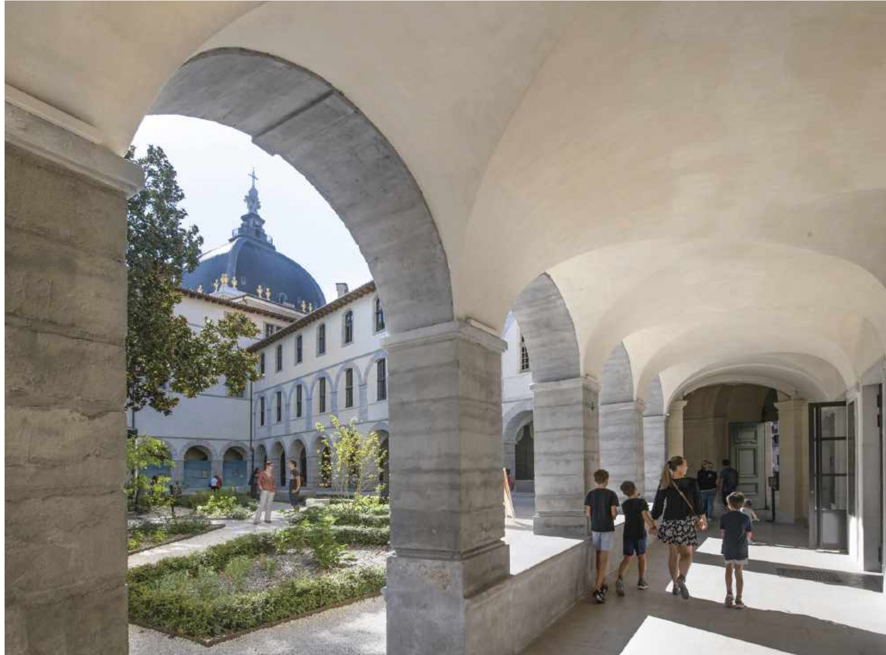
Le grand dôme de l'Hôtel-Dieu vu à travers une arcade de la galerie du grand cloître. Au centre, le jardin est un véritable havre de paix. The main dome of the Hôtel-Dieu seen through an arcade in the gallery around the great cloister. The garden in the middle is a genuine haven of peace.
