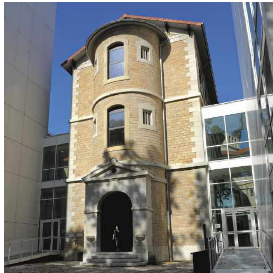
Trois ans plus tard, les bâtiments conservés ont été rénovés et inclus dans des constructions neuves. Three years later, the remaining buildings had been renovated and integrated into new ones.
