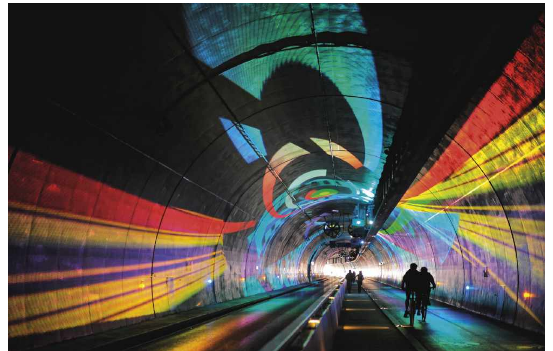
En 2013, l'ancien tunnel sous la Croix-Rousse se voit adjoindre un nouveau tube : le tunnel « modes doux », réservé aux piétons, vélos et transports en commun, avec mise en lumière et ambiance musicale.
