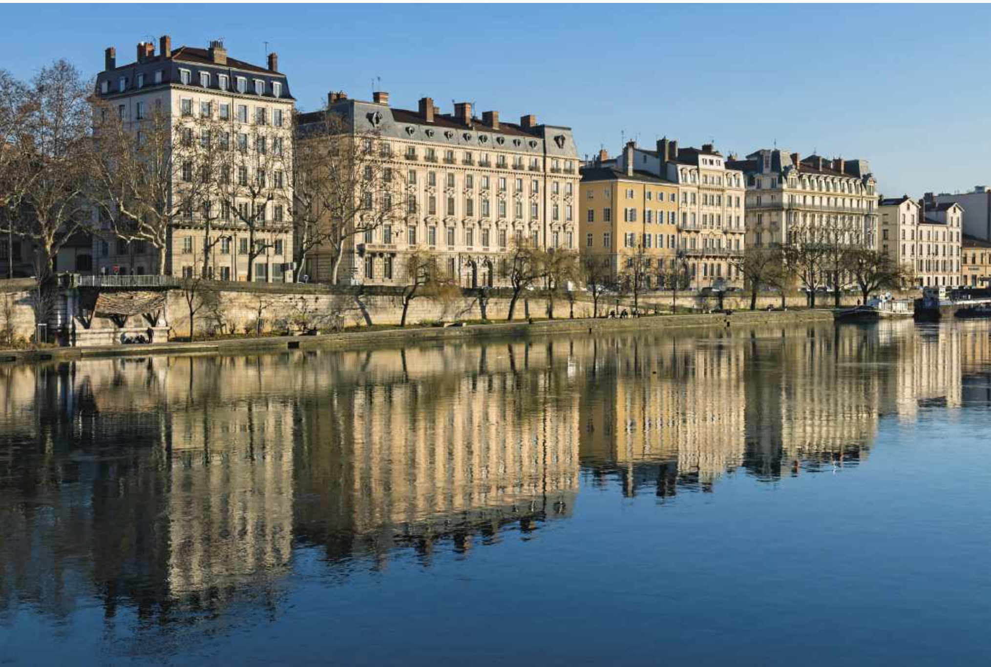
La Saône au quai Maréchal-Joffre. La limite de la zone officielle Unesco passe ici, entre deux immeubles. Le patrimoine n'en continue pas moins au-delà et montre la richesse de la ville.
