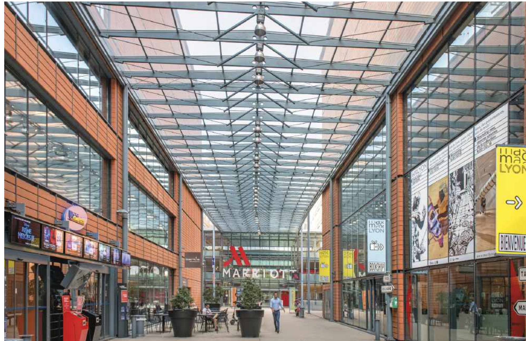
Symbole de l'évolution rapide de la ville, la Cité internationale, trait d'union entre le Rhône et le parc de la Tête d'Or, ensemble dessiné par Renzo Piano, a fait oublier le site de l'ancienne Foire de Lyon. Sa rue piétonne bordée par une double continuité d'immeubles rassemble la vie d'un pôle tertiaire, culturel et touristique, avec les grands hôtels Marriott et Crowne Plaza. Le Centre de congrès accueille des événements internationaux, et la salle de l'Amphithéâtre peut recevoir 3 000 spectateurs.
