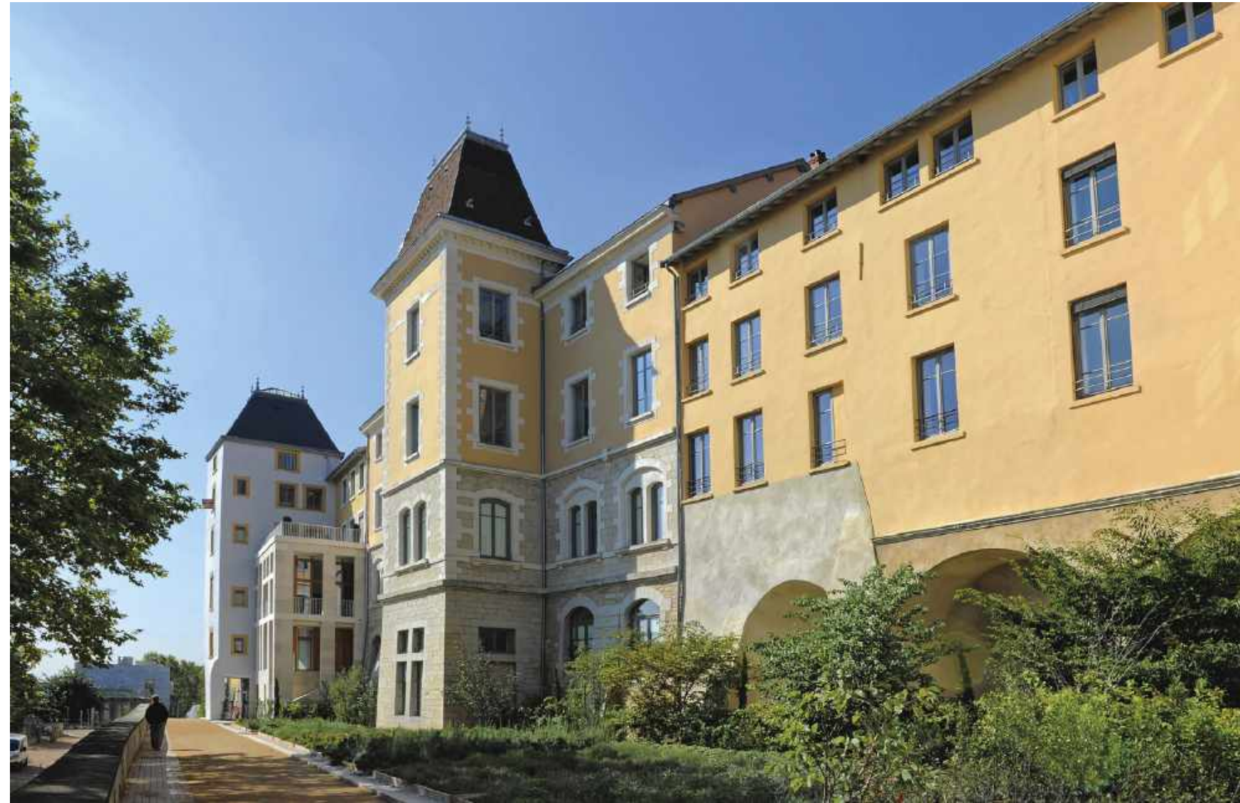
Le couvent de la Visitation de l'Antiquaille devient un hôpital et asile au début du XIX e siècle. Fermé en 2003, il a été rénové et complété par de nouveaux bâtiments à partir de 2010 : des bureaux, des logements, une résidence universitaire, un restaurant gastronomique, un hôtel 5 étoiles et un espace culturel occupent ce site doté d'un point de vue exceptionnel sur la ville.
