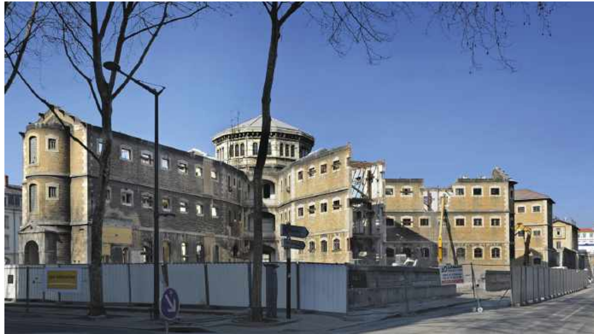
Fin 2012, dans le quartier de Perrache, commence la démolition d'une partie de l'ancienne prison Saint-Paul. Part of the former Saint-Paul Prison in the Perrache district was demolished starting at the end of 2012.
